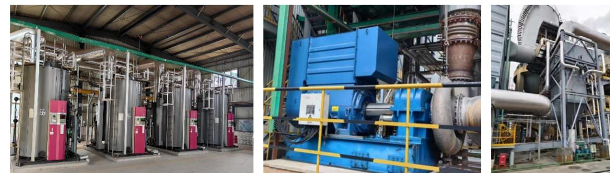
江西生产基地使用高效锅炉、空压机与余热锅炉
