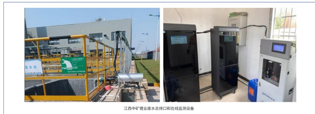
外排废水主要包括锅炉定期排水、地面冲洗废水、真空泵废水、锅炉软水制备废水及生活污水。工业废水处理系统遵循雨污分流、清污分流、分质处理的设计原则，完善厂区雨水管网与污水管网的分类建设。生产区生活污水经预处理后，与地面冲洗废水、真空泵废水等汇入厂区污水处理站，采用“调节池→中和反应池→混凝沉淀池→絮凝沉淀池→水解酸化池→接触氧化池→二沉池”组合工艺进行处理，出水水质达到《无机化学工业污染物排放标准》(GB31573-2015) 表 1 中间接排放标准限值要求。
